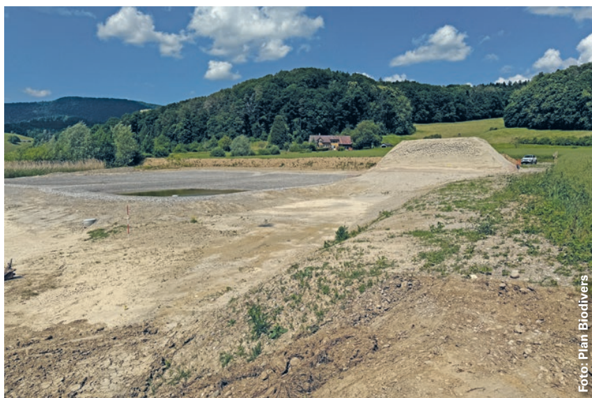
Im ehemaligen Kiesabbaugebiet Flüefeld-Tägerhardrütene entsteht eine neue vielfältige Landschaft.
